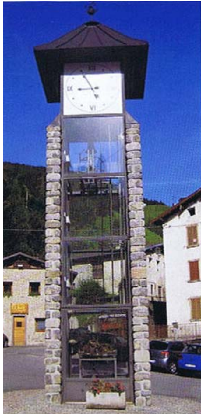
Torre dell'orologio all'ingresso di Valtorta
